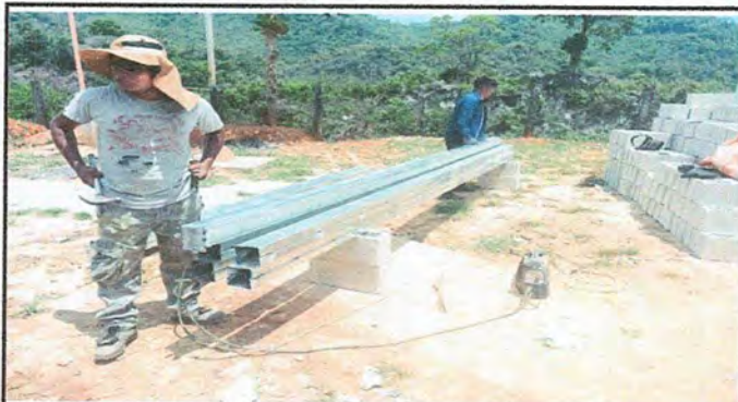
Foto 3: Preparacion de estructura metalica modulo I.
