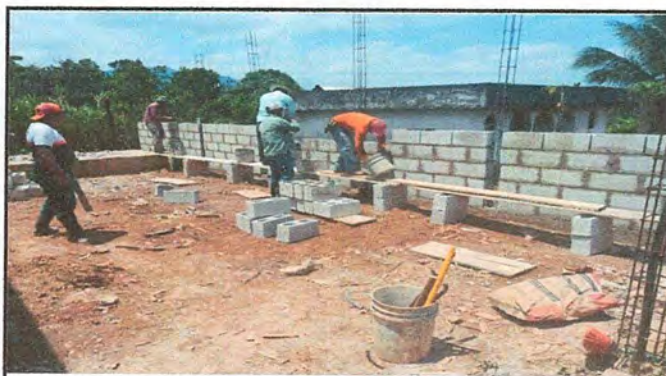
Foto 4: Rehabilitacion de Cocina.
