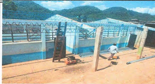
Foto 2: Mantenimiento de estructura metalica, previo a la instalacion de costaneras.
