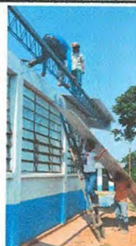
Foto 6: Instalcion de laminas troqueladas.
